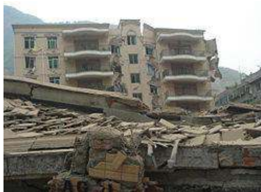
四川大地震により倒壊する建物
