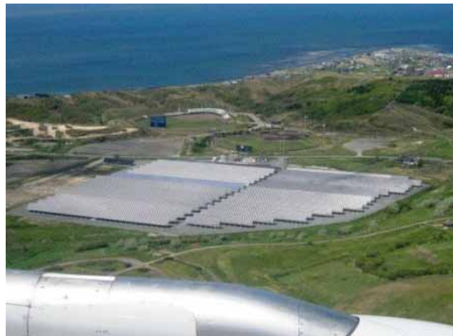
上空から見た太陽光発電パネル
